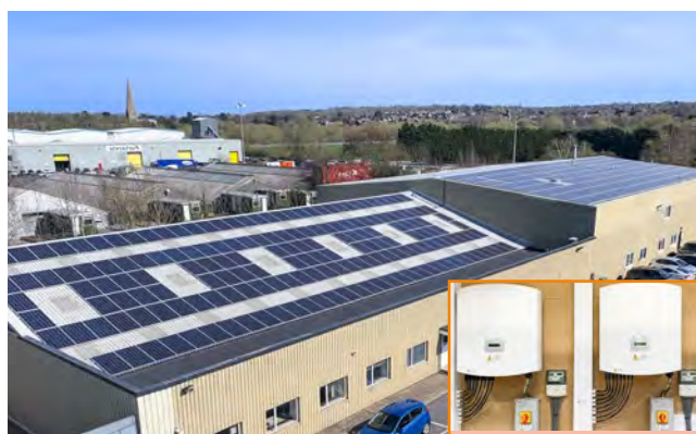
Grundfos Rooftop, UK 123.4kW
