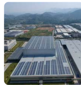
国镜药业光伏电站
